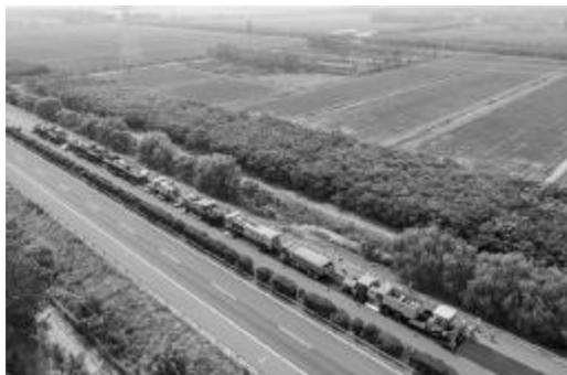
图 1 集萃公司热再生机组施工现场
