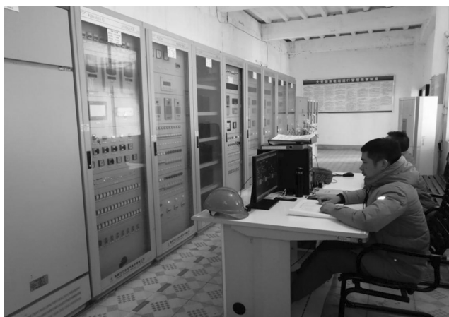
图2 小型水电站微机监控运行
