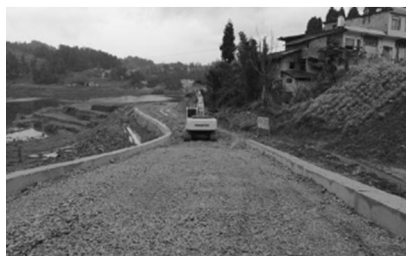
图 1 农村公路建设
