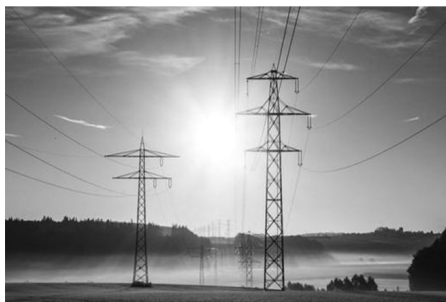
图 1 输变电工程(一)
