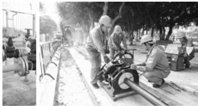
图1 燃气工程施工
