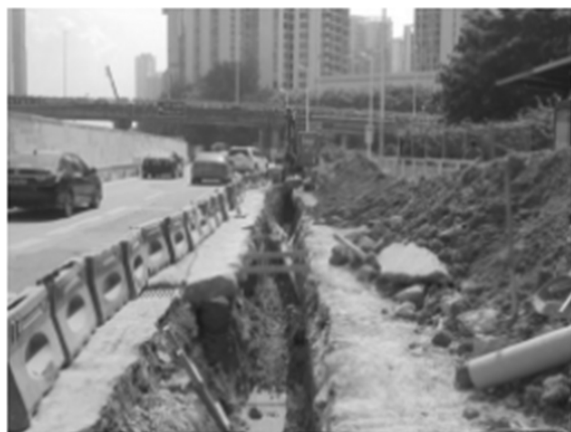
图2 管沟开挖
