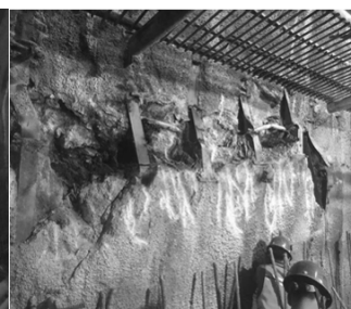
图 2 初支脱落
