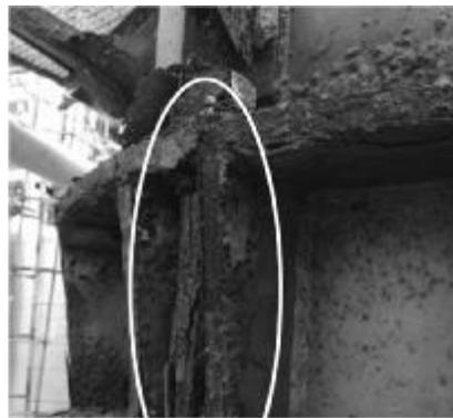
图2 中间丙烯洗涤塔地脚螺栓腐蚀
