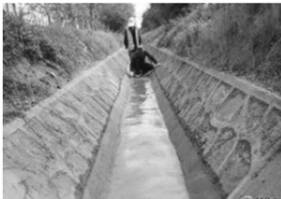
图2 路基排水施工
