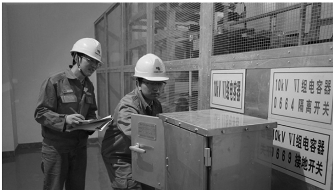
图2 电力工程检查
