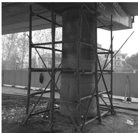
图1 飞石飞散防护措施现场
