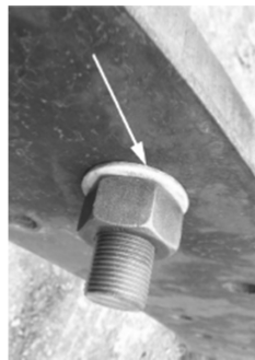
图 1 垫圈的安装示意
