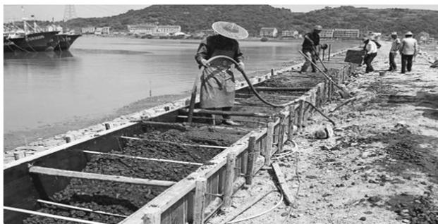
图 2 混凝土的浇筑
