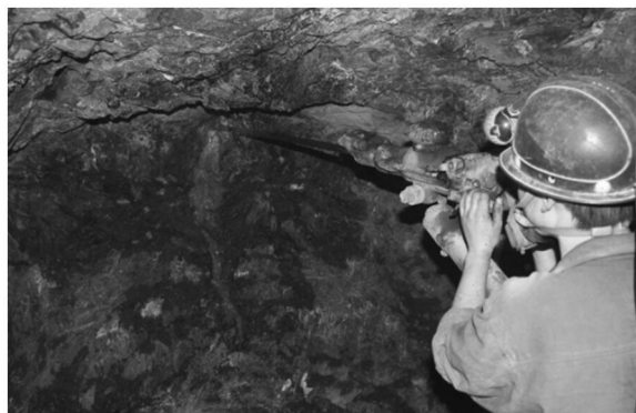
图2 爆破掘进钻眼施工
