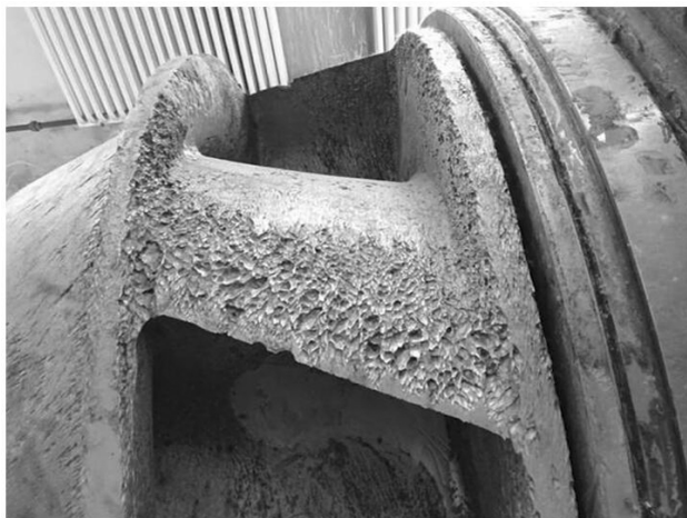
图 2 凝结水泵汽蚀
