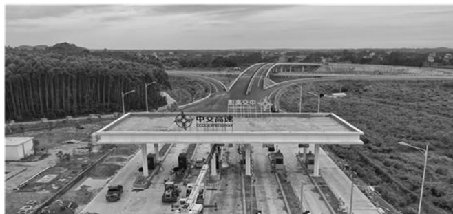
图1 某高速公路机电工程
