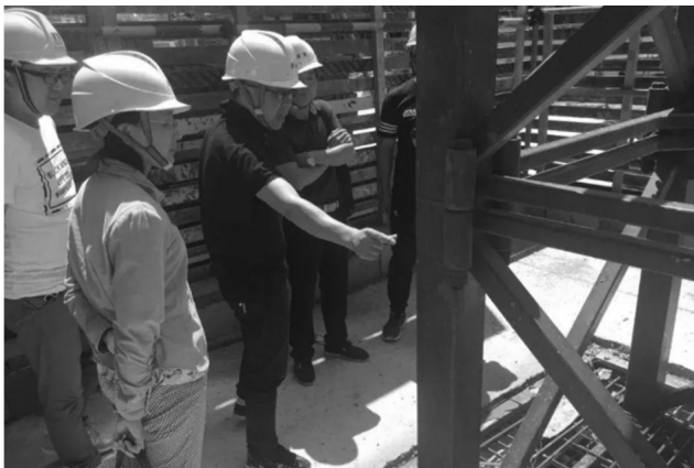
图1 施工现场设备设施安全检查
