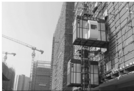
图2 建筑工地现场电梯使用
