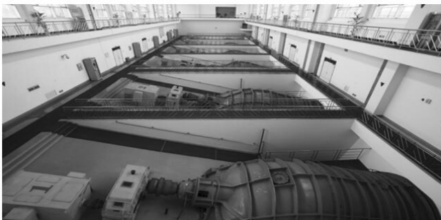
图 3 某地水利泵闸站
