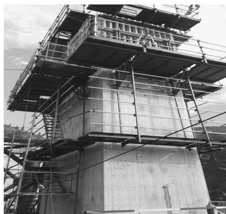
图1 大型悬臂模板
