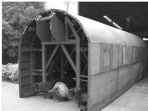
图2 尾水管模板
