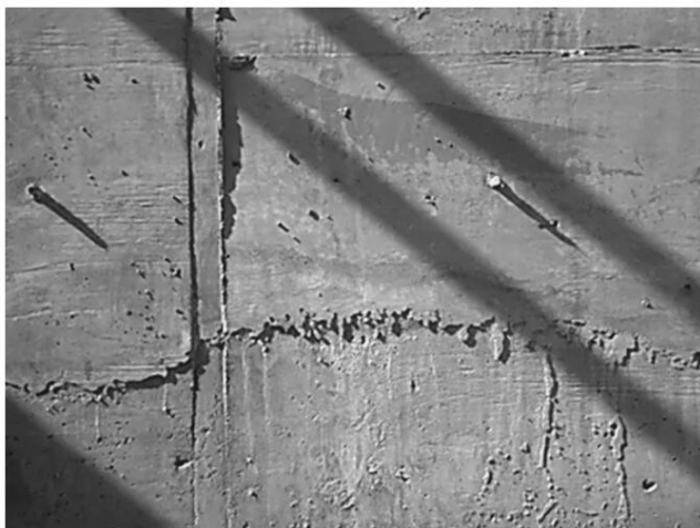
图2 修补混凝土裂缝
