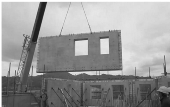
图 4 装配式构件起吊安装
