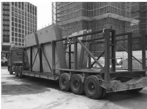
图 3 预制构件运输
