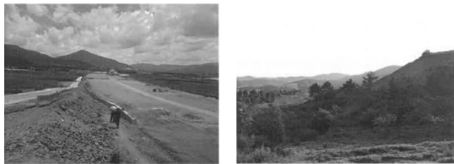
图1 武定至倘甸至寻甸高速公路一标段三分部施工现场
