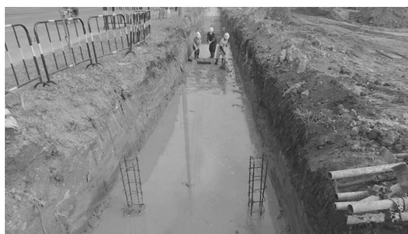
图5 电缆沟敷设施工现场
