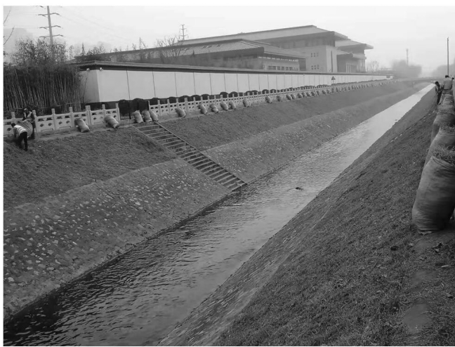
图2 水利工程的明渠
