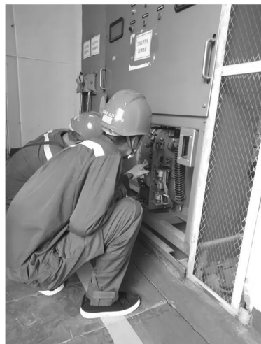
图1 对变电设备进行检修更换
