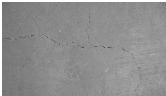
图 1 干缩裂缝
